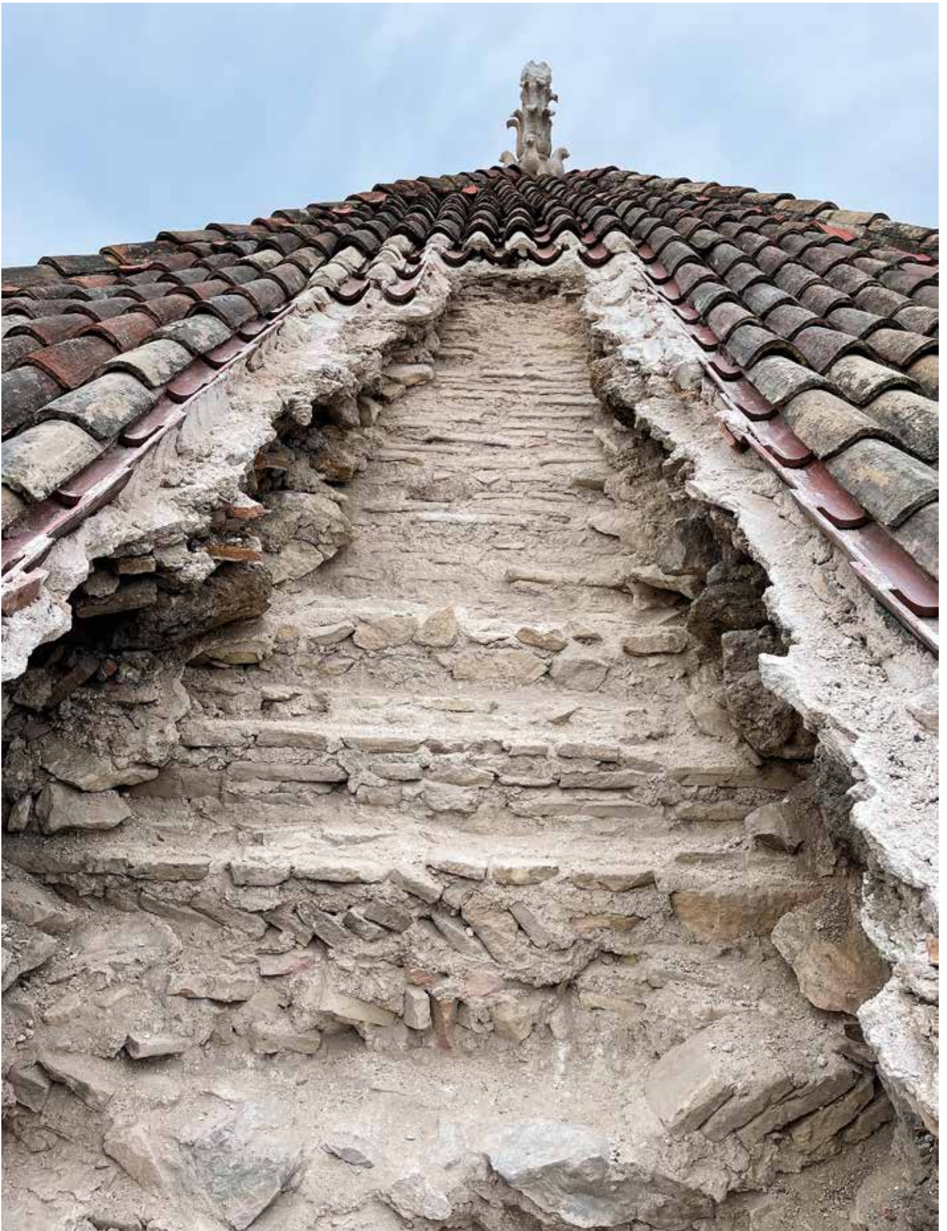
Slika 5. Sonda na sjevernoj strani krova splitske katedrale (Dioklecijanov mauzolej) s pogledom na ekstrados (snimio R. Bužančić)
